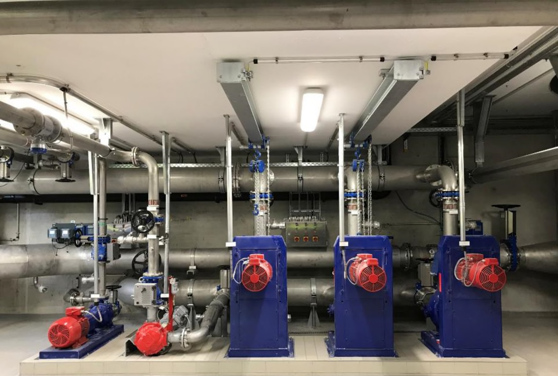
Neubau Kläranlage Scheßlitz Ausführungsbeispiel Rücklaufschlammwerk
